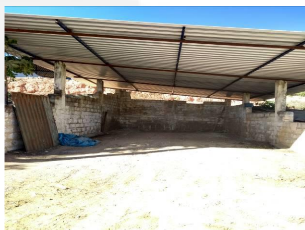
Foto 06. Depósito temporário de resíduos.
