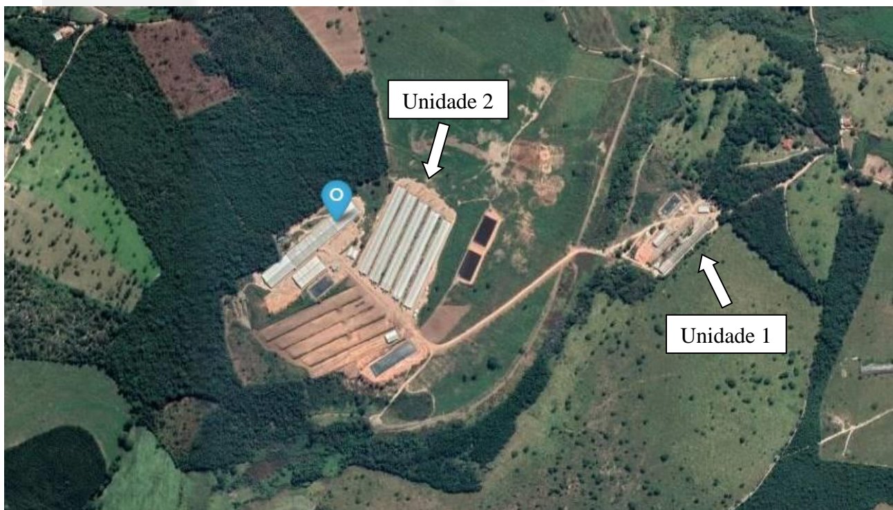
Figura 01: Vista aérea do empreendimento e seu entorno. Fonte: IDESisema.
