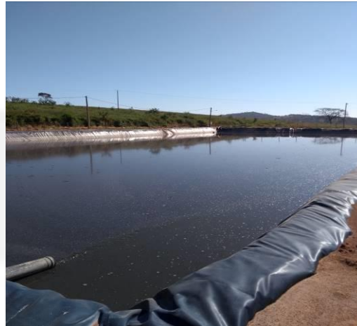
Foto 02. Lagoa de estabilização.
