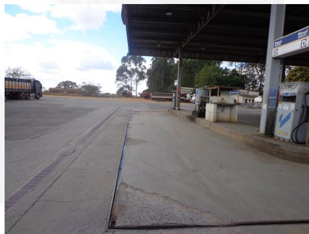
Foto 04. Pista e canaleta danificadas
