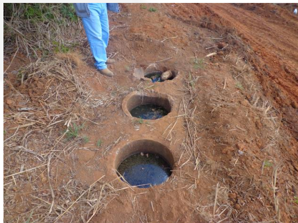
Foto 10. Caixa de passagem e sumidouro
