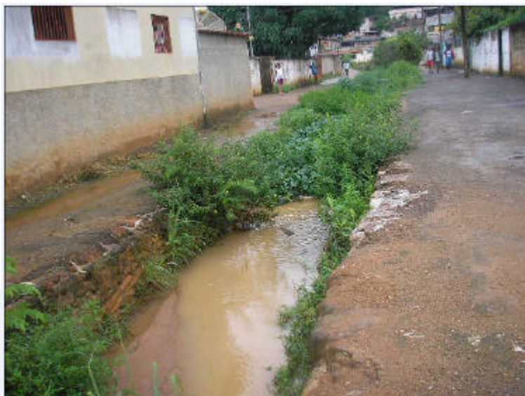
Foto 03: Vista parcial de montante para jusante do ponto inicial da galeria fechada do afluente do Córrego Caladinho.
