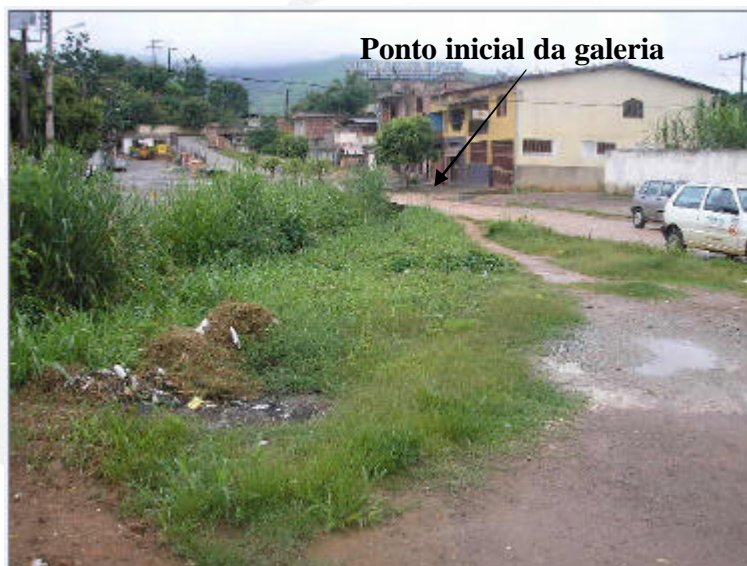
Foto 02: Vista parcial da área onde começará as obras da galeria fechada do afluente do Córrego Caladinho.
