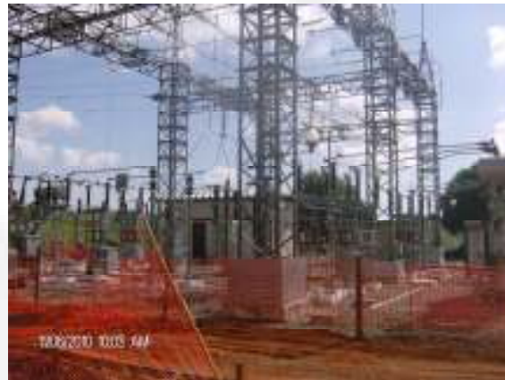
Foto 03. Obras de ampliação da SE Eng.º Caldas.
