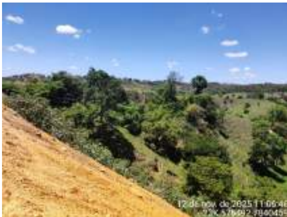
Foto 24: Visada parcial da área da obra emergencial abaixo do talude.
