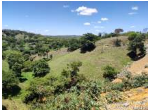
Foto 25: Visada parcial da área da obra emergencial abaixo do talude.
