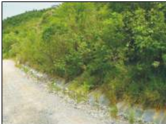
Foto 8: Canaletas revestidas por dolomito.
