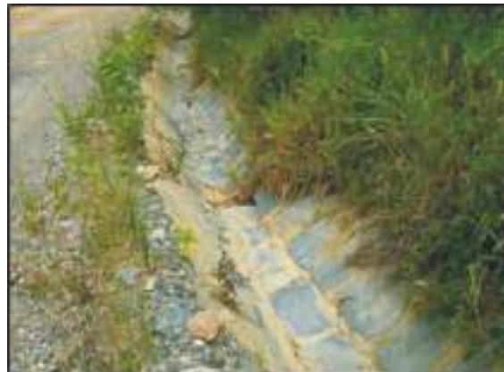
Foto 9: Canaletas revestidas por dolomito.
