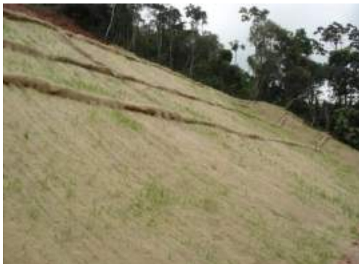
Foto 11: Exemplo de uso de geotêxtil de fibra de coco.
