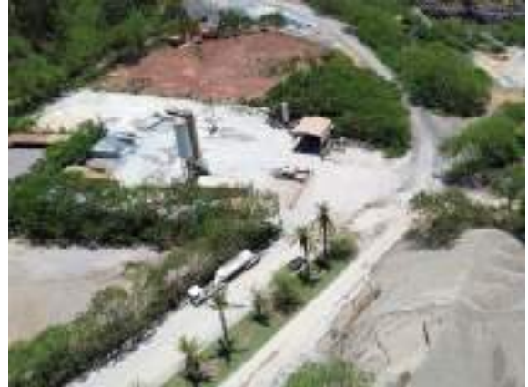
Foto 10: Diferentes estruturas operacionais, pátios, depósitos, pilhas e acessos na ADA.
