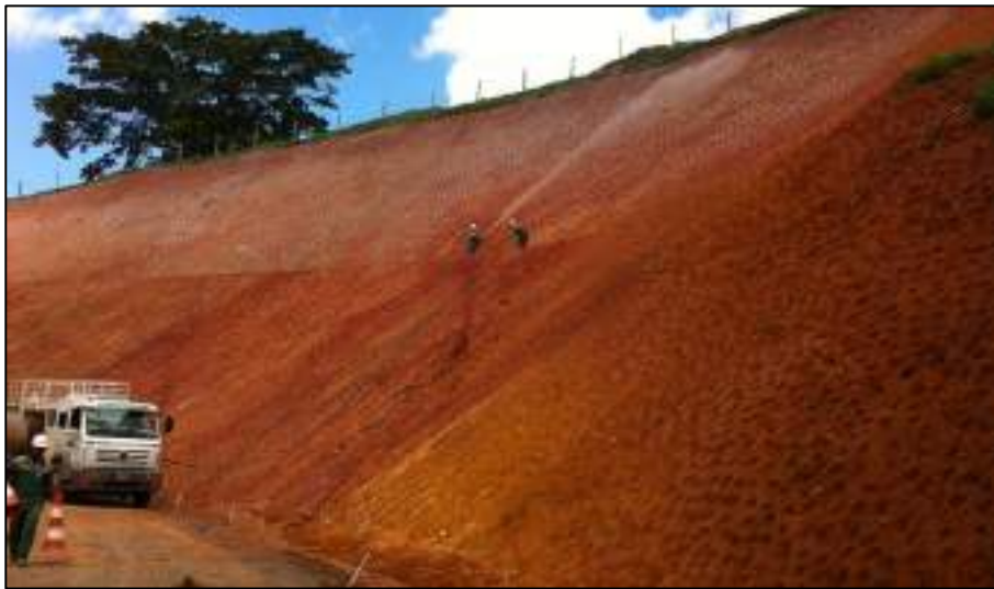
Foto 10: Hidrossemeadura e escarificação do solo em talude.
