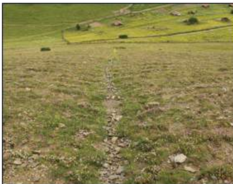
Foto 15: Presença de sulcos de erosão causadas pela confluência de águas pluviais.
