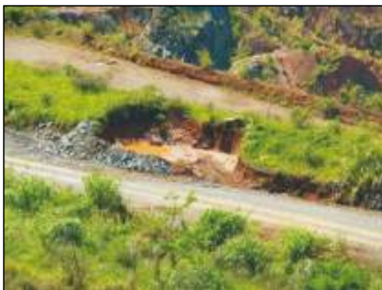
Foto 7: Exemplo de sistema de de drenagem em vias de acesso compostas por canaletas e bacias de decantação.
