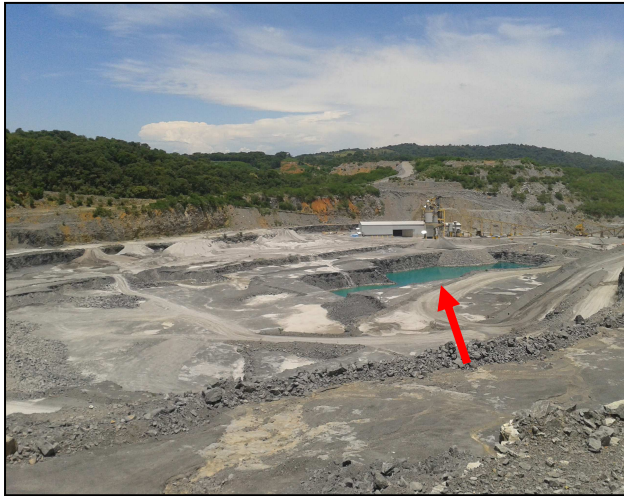
Vista da Mina, tanque estocagem de água pluvial para utilização em aspersão de vias.
