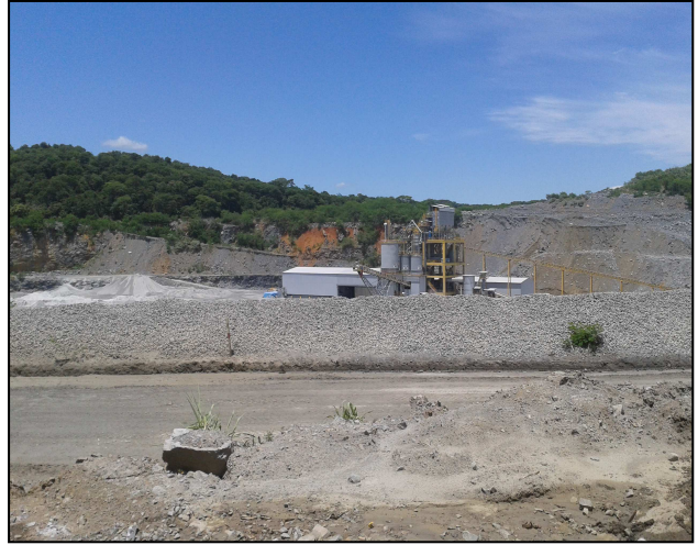
Vista da Mina, área de beneficiamento.
