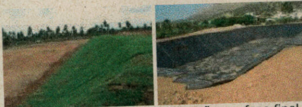
a) talude das lagoas b) impermeabilização em fase final da lagoa
