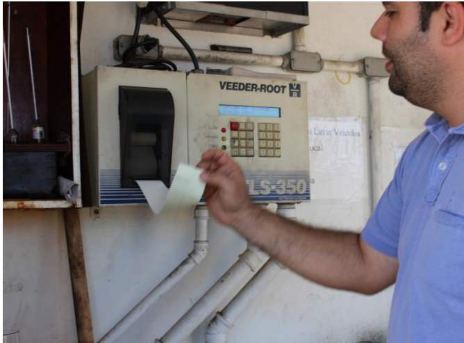
Foto 7: Aparelho Veeder-root (monitoramento intersticial).
