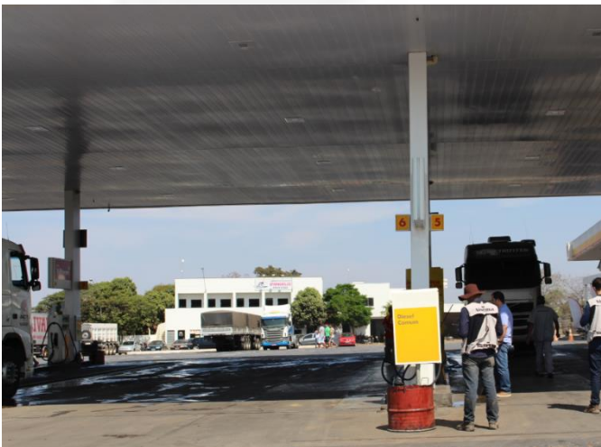
Foto 3: Pista de abastecimento de diesel.
