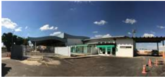
Foto 07: SETOR G (Relatório Fotográfico para licenciamento, julho de 2020)
