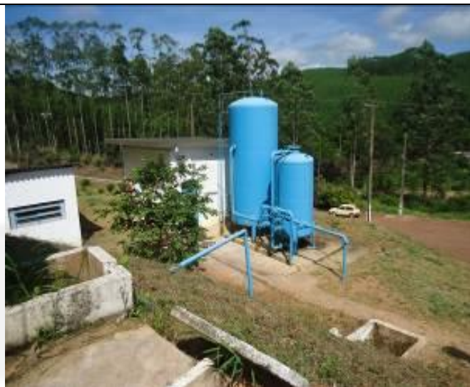
Foto 06. Reservatório de água tratada
