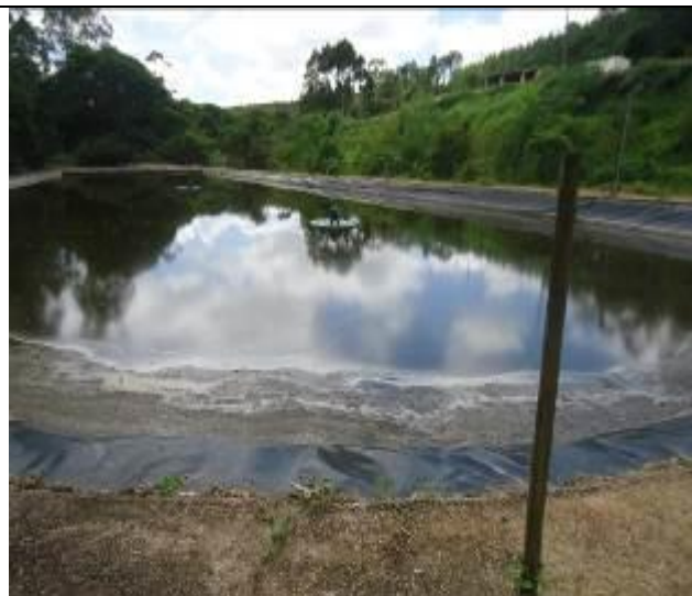
Foto 05. Lagoa para tratamento de efluentes líquidos industriais.
