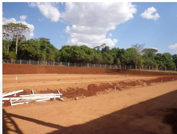
Foto 12. Terreno terraplanado para construção.
