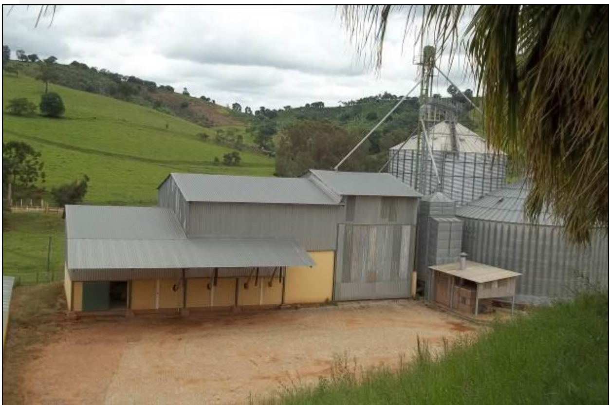
Figura 04: Fábrica de ração existente na Granja Mayra I. Fonte: Imagem obtida em vistoria.
