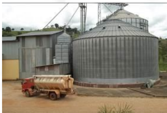
Foto 04. Silos para armazenamento.
