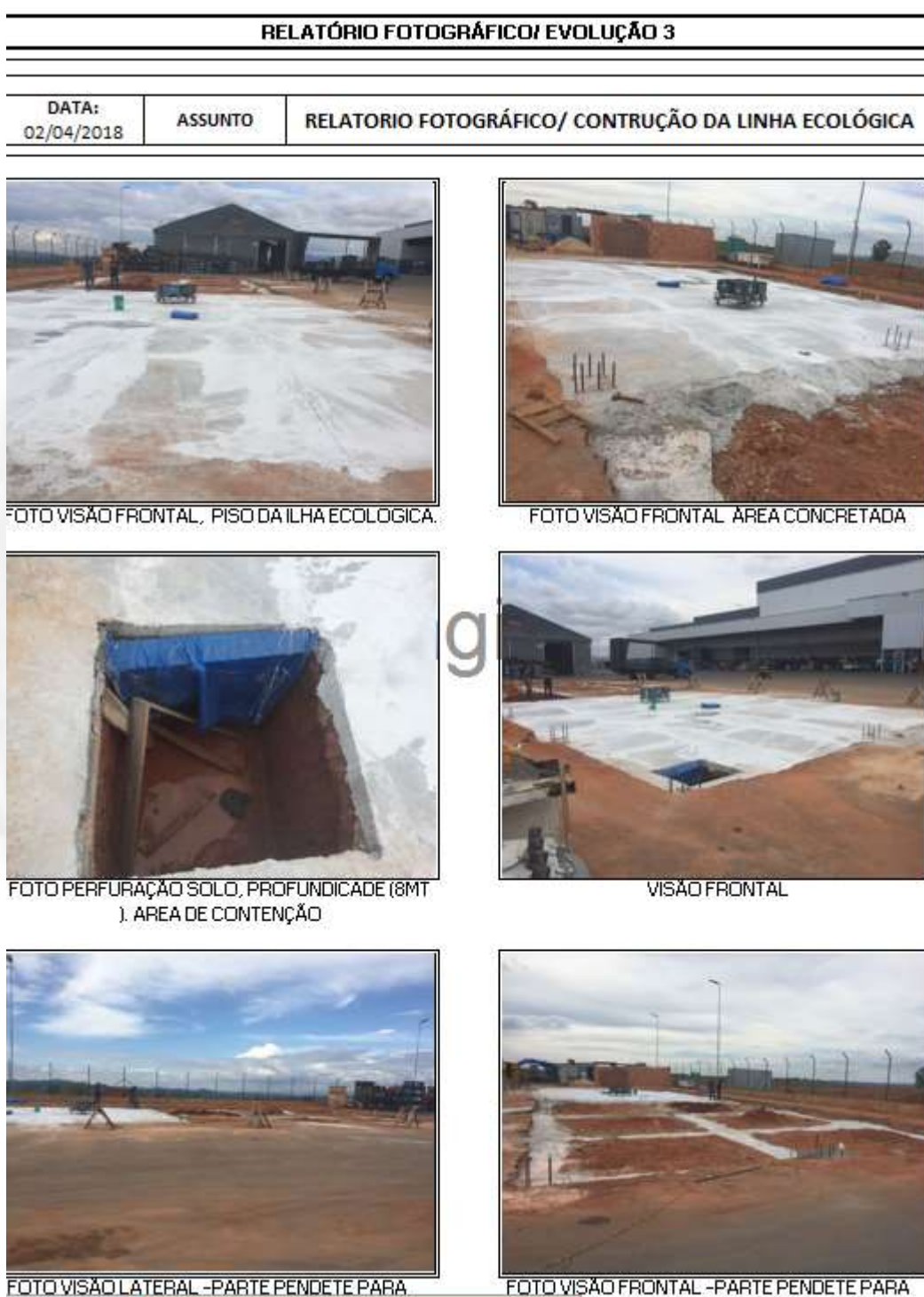
Figura 03: Relatório fotográfico do início de implantação do depósito temporário de resíduos.
