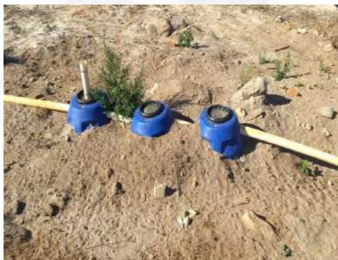
Foto 04: Sistema fossa-filtro-sumidouro existente
