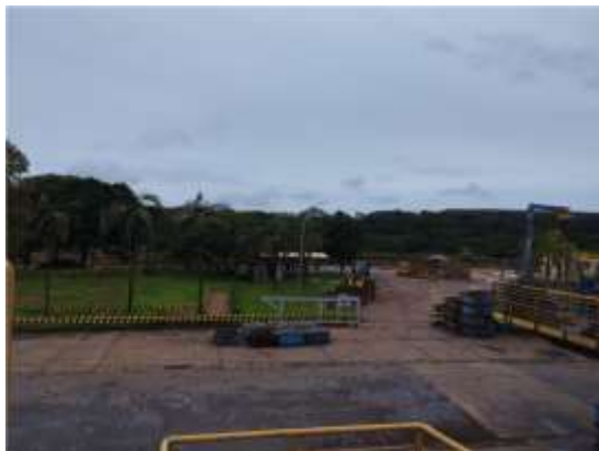
Foto 01. Local de instalação da ampliação
