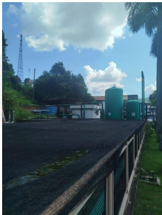
Estação de Tratamento de Água - ETA
