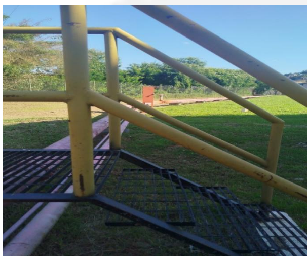
Tubulação sistema de incêndio – intervenção APP
