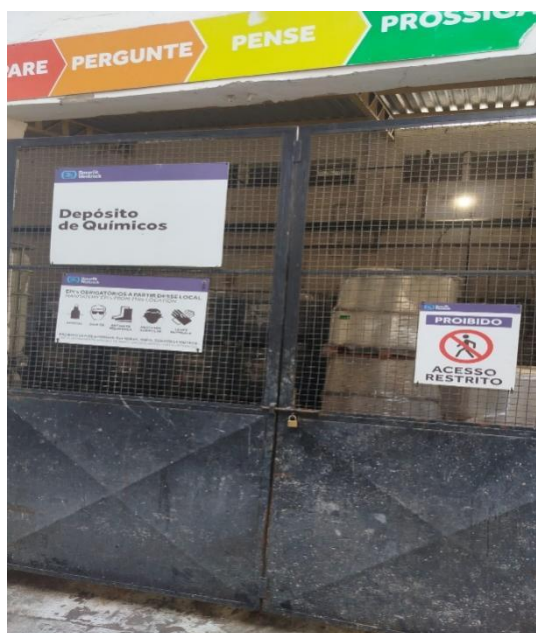
Depósito de produtos químicos
