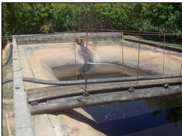
**Foto 04:** Caixa coletora do chorume oriundo da decomposição dos resíduos.
