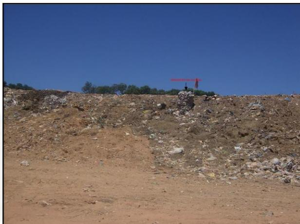
**Foto 02:** Frente do maciço e (em destaque) dreno vertical dos gases.
