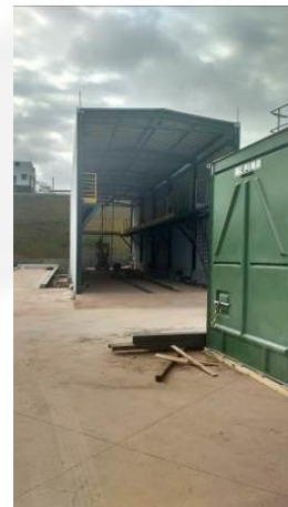
Foto 04. Novo Lavador de Veículos
