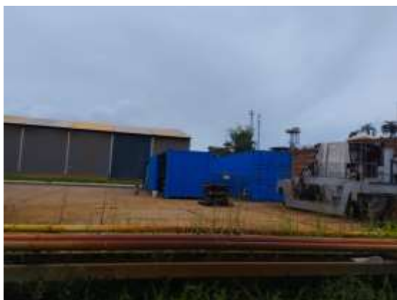
Foto 03. Área onde serão instaladas infraestruturas de apoio
