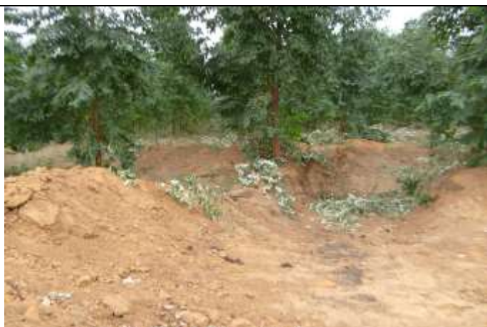
Foto 9 – Camalhões e bacias de contenção nas estradas no interior dos plantios.
