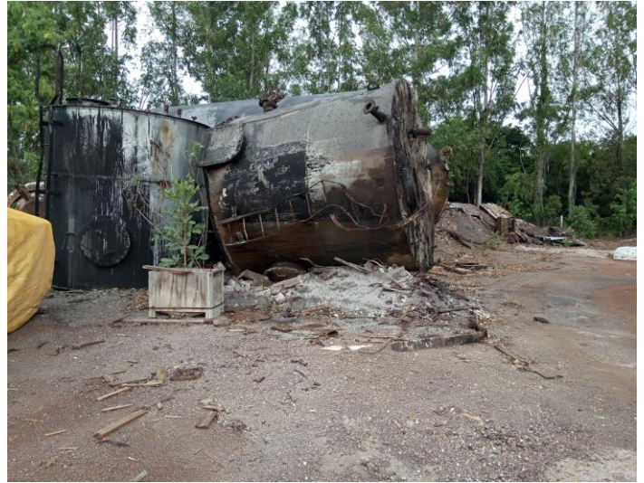
Foto 11: Tanques da antiga central de BPF
