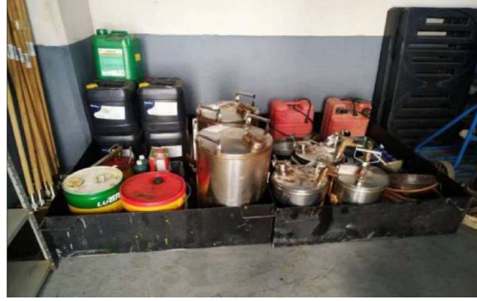
Resíduos de Classe I dentro da contenção
