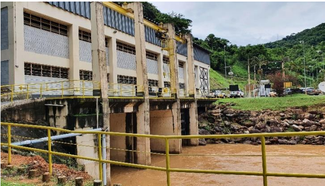
Canal de Fuga
