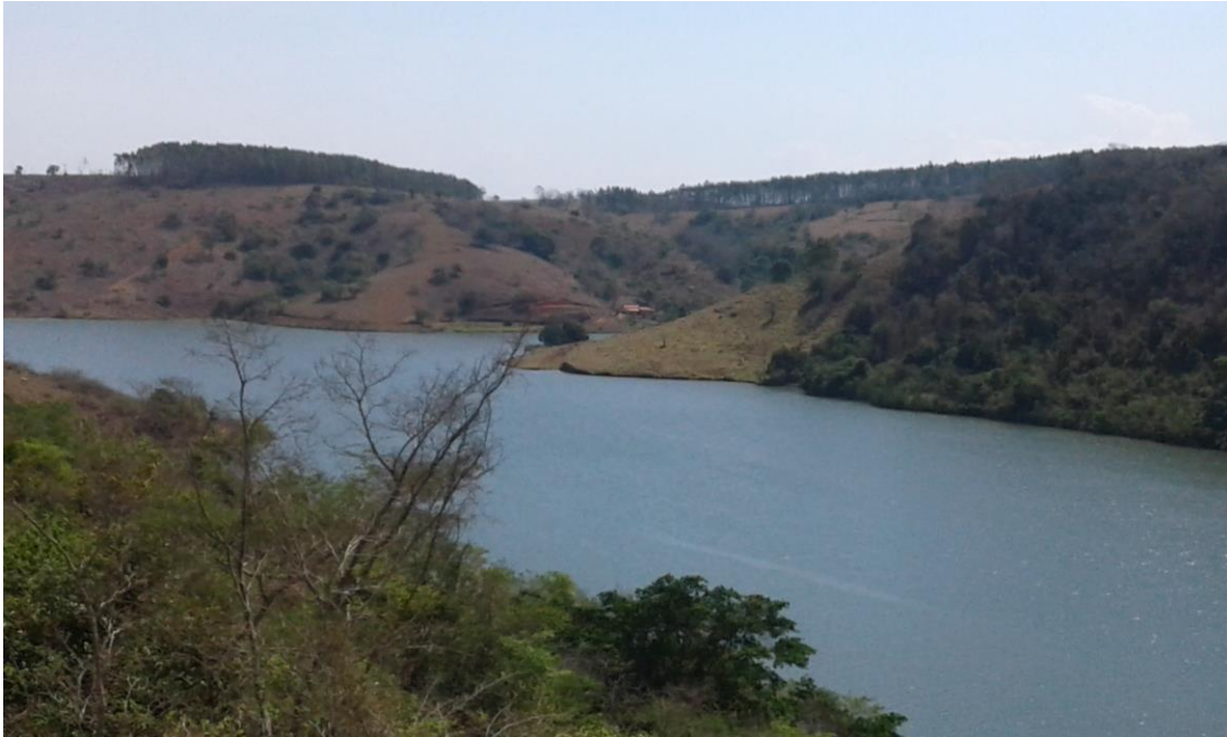
Figura 03 - Detalhe do reservatório da PCH Ivan Botelho I.
