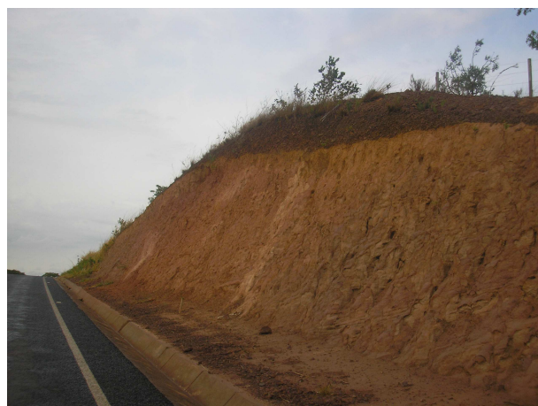
Foto 02. Corte de estrada
