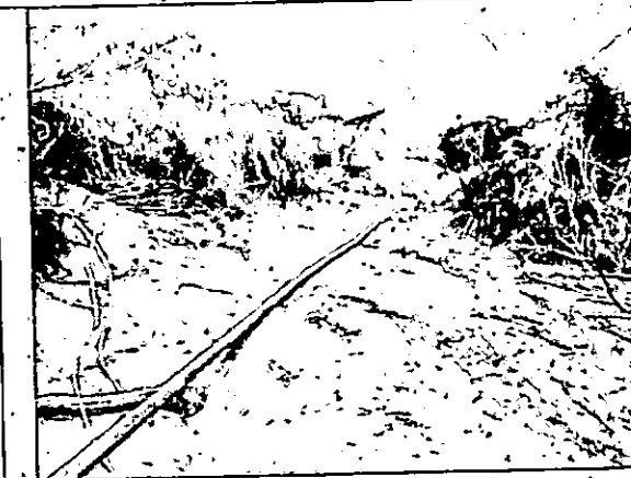
Foto 06: Desmate para passagem de tubulação de recalque.
