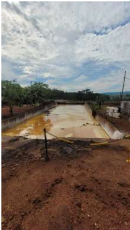
Foto 01. Lagoa de recebimento dos efluentes
