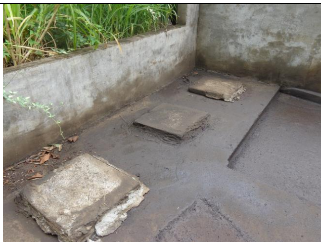
Foto 05a: Caixa separadora de água e óleo; 13/03/2015.
