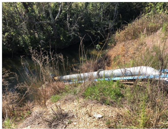
Foto 02. Captação superficial de água
