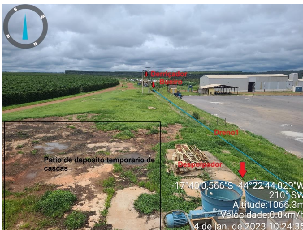
Figura 123 - Aspecto geral do sistema de beneficiamento. (fonte: Processo SLA: 2279/2022)
