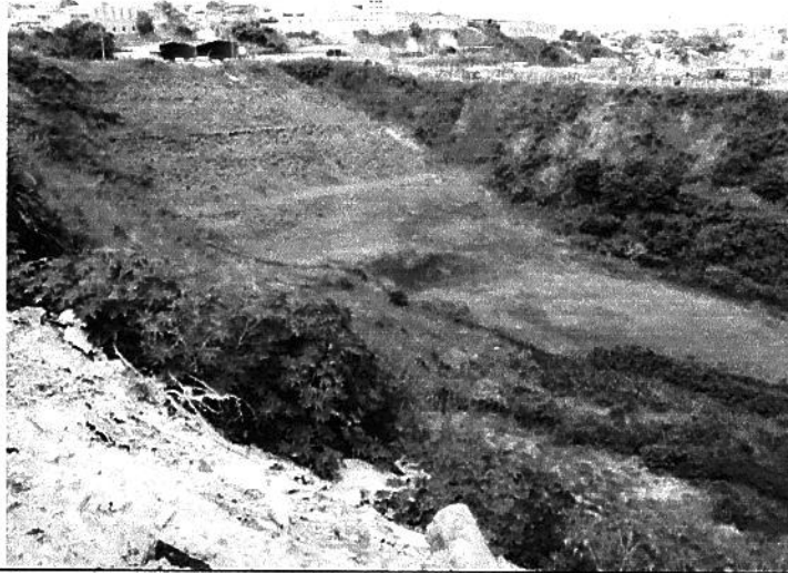
Foto 04: Lado esquerdo do bota-fora. Inclinação do local com a presença de vegetação brejeira taboa
