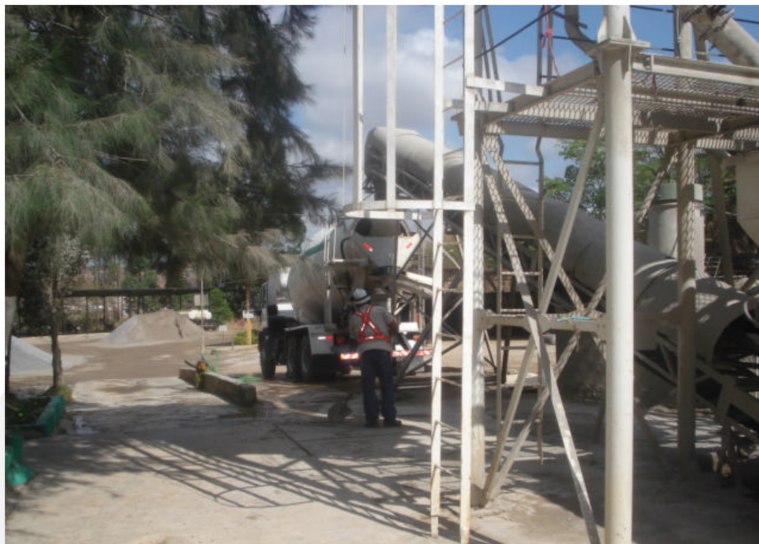
Fig. 03: Caminhão-betoneira sendo abastecido com a mistura cimento, agregados e água.
