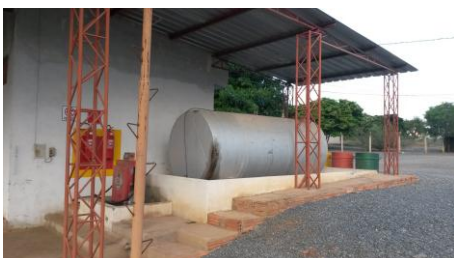
Foto 07: Área de abastecimento
