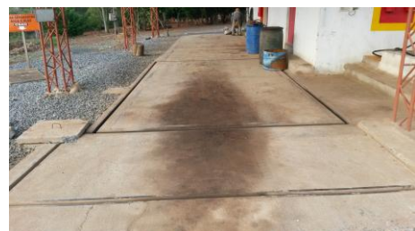
Foto 08: Área de abastecimento
