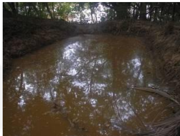
Foto 02. Dique de contenção de sedimentos.
