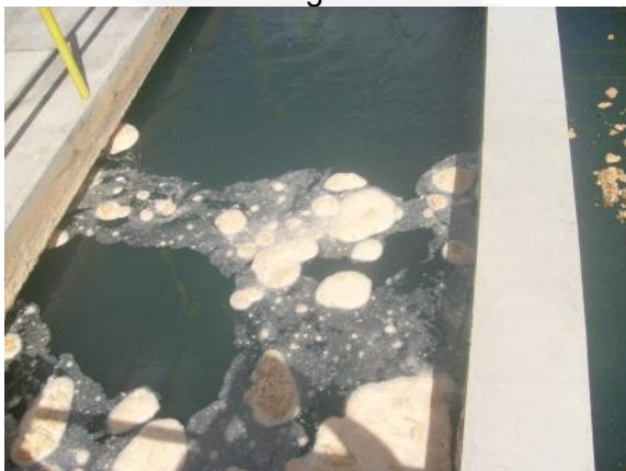
Foto 03. Floculador após a aplicação do coagulante
