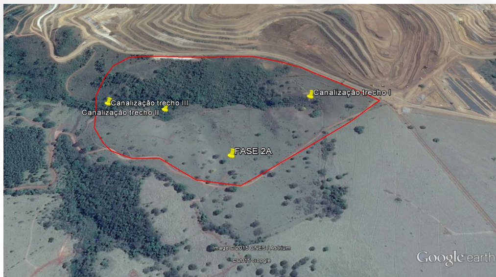
Fig. 04 – Canalizações de curso d'água – Ampliação da pilha de estéril
