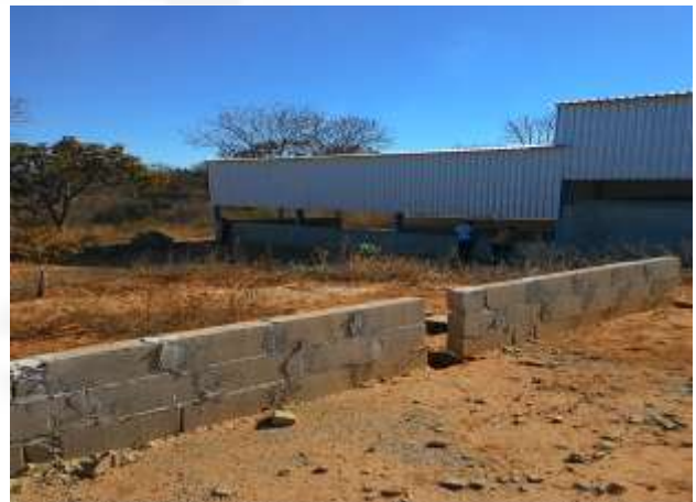
Foto 02. Estrutura coberta da ETE
