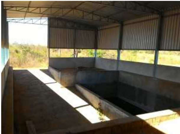
Foto 01. Estrutura da Estação de Tratamento de Esgoto
