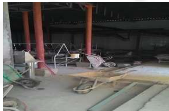
Foto 04. Em fase de instalação
