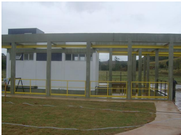
Foto 01. Vista da Estação Elevatória Final.
