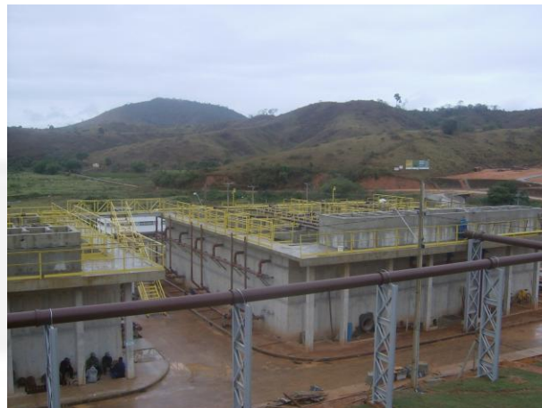
Foto 02. Reatores anaeróbios de fluxo ascendente com manta de lodo – UASB.
