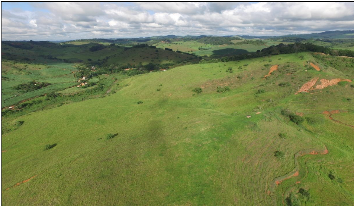
Foto 4: Visão geral da área 02, localizada na vertente onde não haverá instalação da unidade de aterragem, corresponde a área de influência direta – AID da CTR BITURUNA
