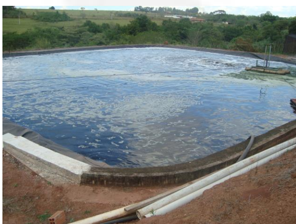
Sistema de Tratamento – Lagoa Aerada
