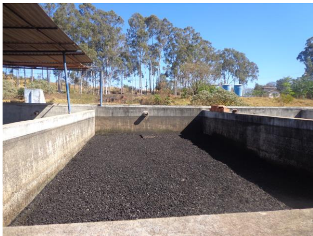
Leitos de secagem de lodo.
