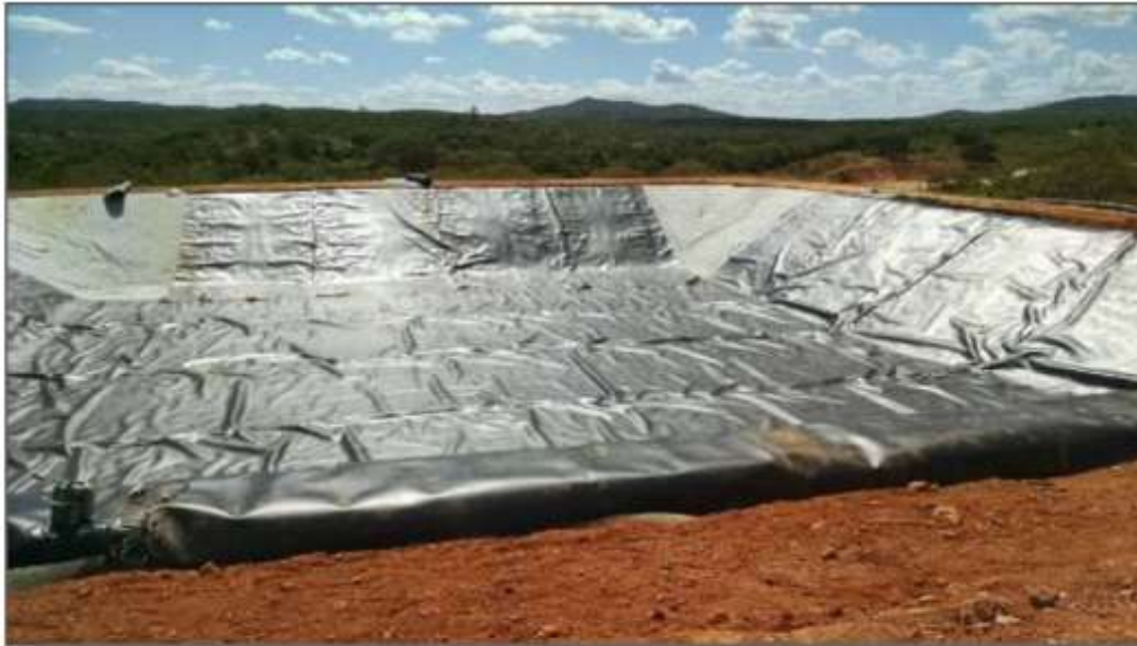
Lagoa de pré tratamento do chorume impermeabilizada com geocomposto bentonítico e geomembrana de PEAD texturizada de 2mm de espessura
