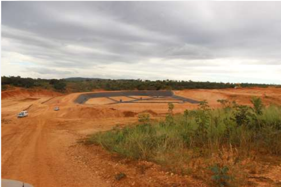
FOTO 01 – VISTA GERAL DA 1ª CÉLULA DO ATERRO SANITÁRIO
