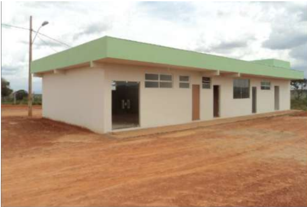
Sala do administrativo, refeitório, almoxarifado e vestiário.
