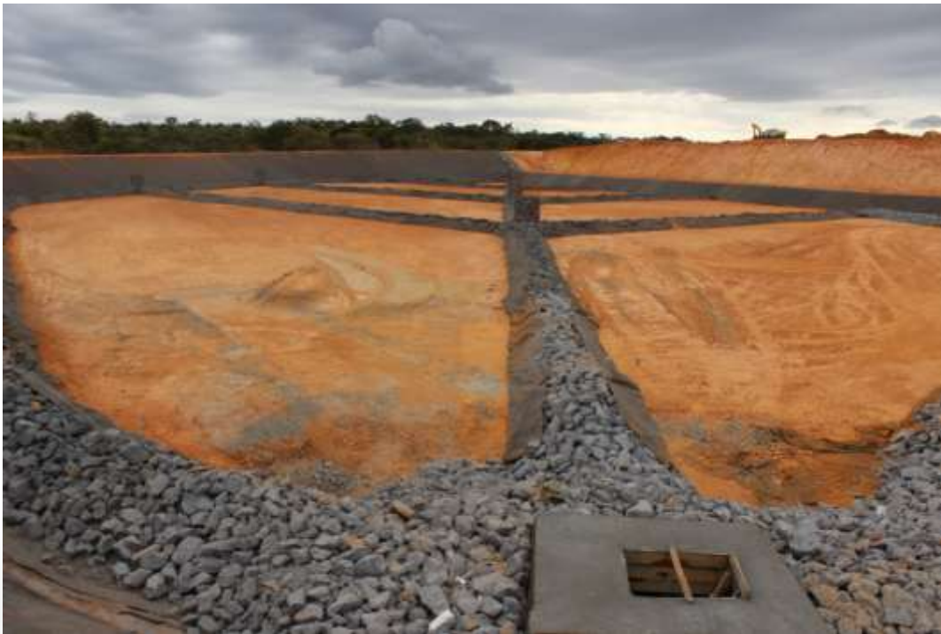
FOTO 03 – PRIMEIRA CÉLULA PRONTA PARA RECEBER OS RESÍDUOS SÓLIDOS URBANOS DO ATERRO SANITÁRIO
