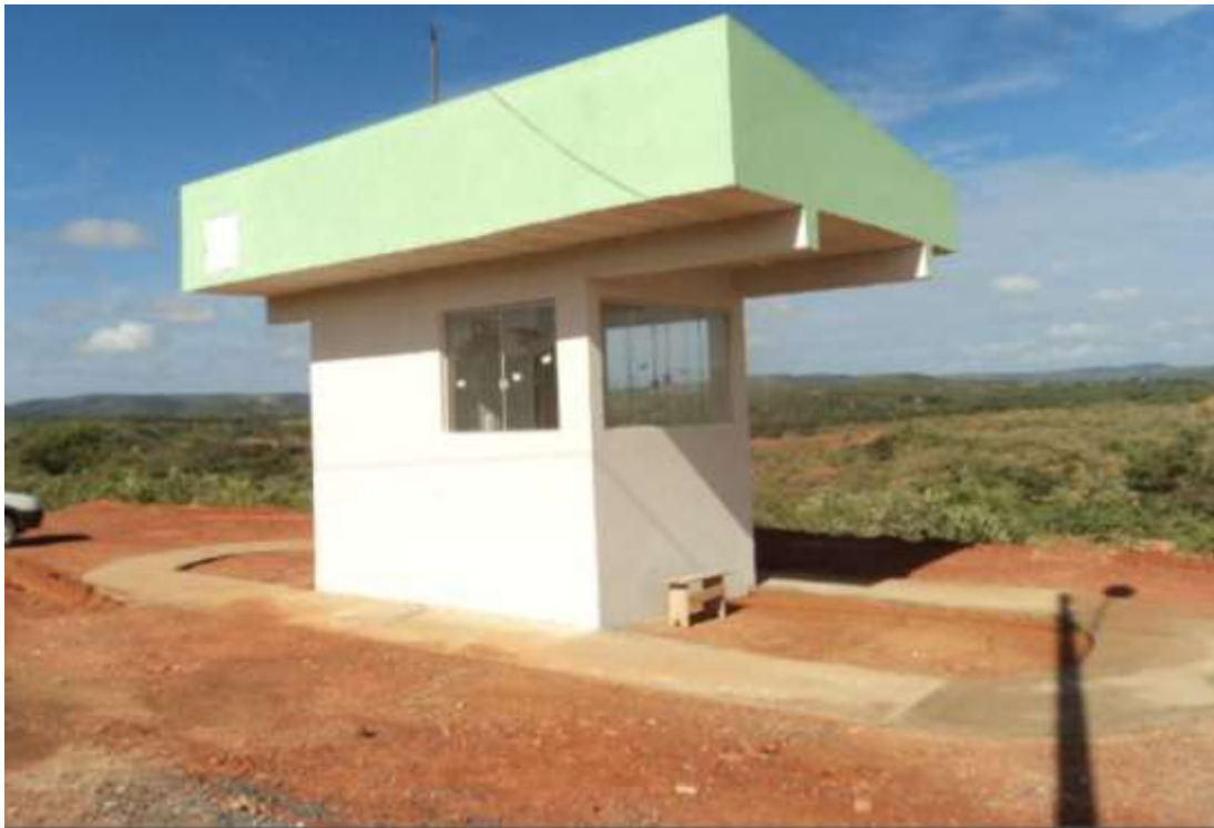
Portaria instalada na CTRS para controle de acesso de motoristas, colaboradores e visitantes.
