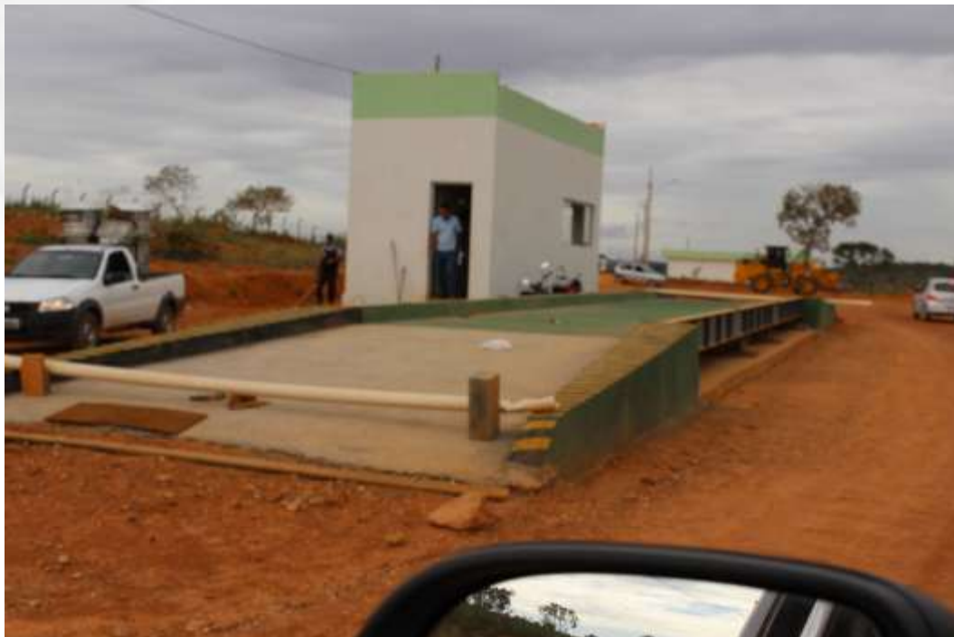
FOTO 06 – BALANÇA RODOVIÁRIA - CAPACIDADE 80 TONELADAS
