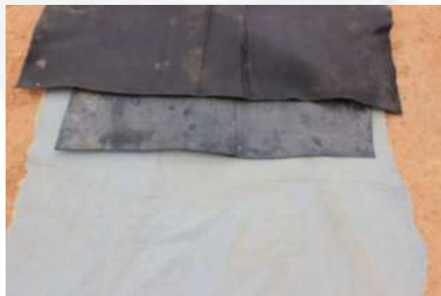
FOTO 02 – geocomposto bentonítico, uma geomembrana de polietileno de alta densidade – PEAD, com espessura de 2,0 mm e um Geotêxtil instalados na base do aterro sanitário
