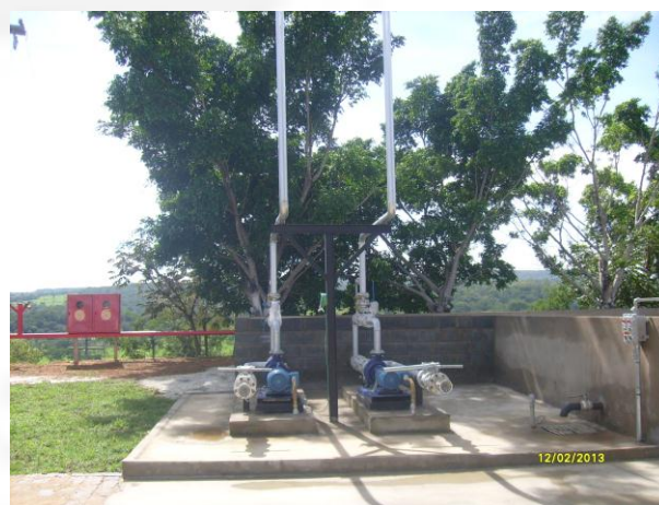
Foto 02. Praça de Bombas
