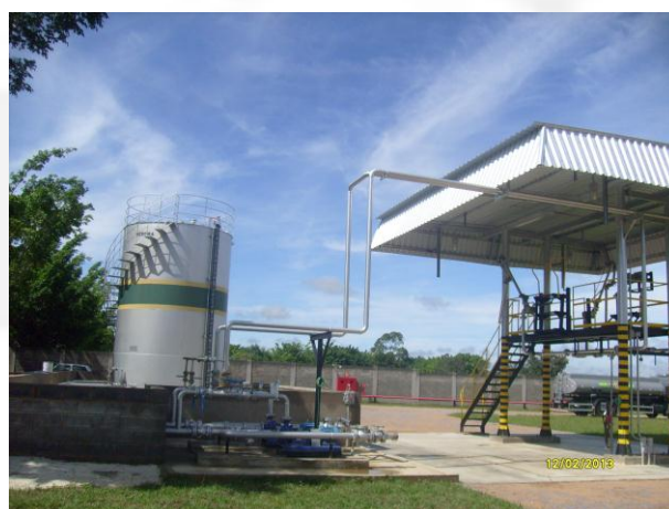
Foto 04. Plataforma de carregamento
