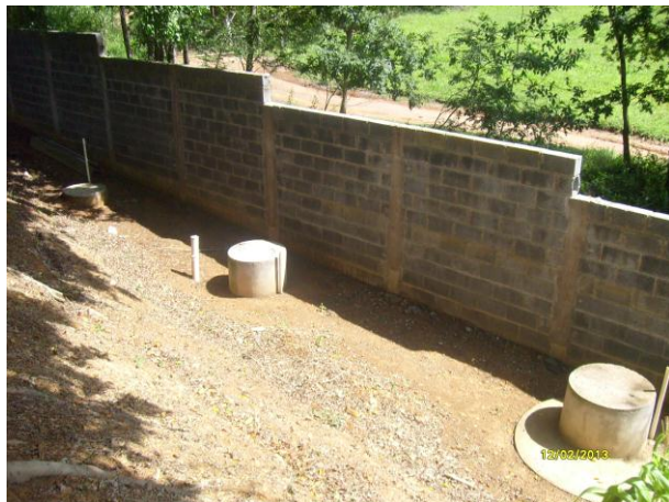
Foto 05. Sistema Fossa séptica, filtro e sumidouro
