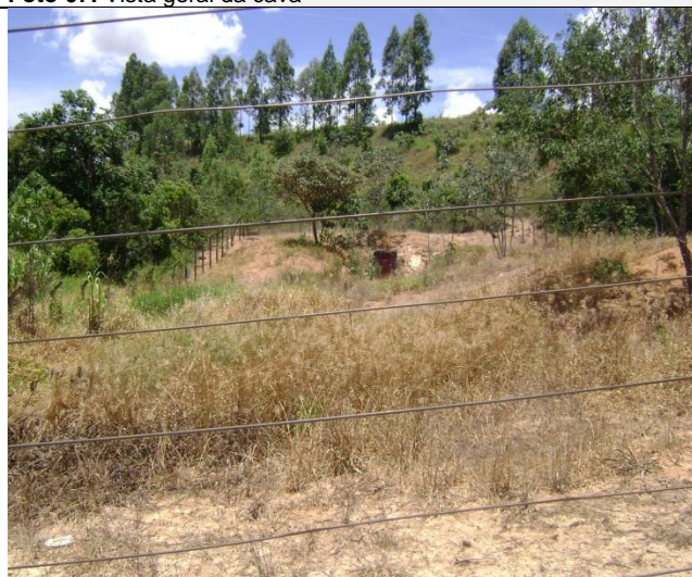
Foto 09: Vista do local onde será feita a estrada de acesso para a pilha de estéril ao fundo. Destaque para revegetação do talude e eucalipto no talude.
