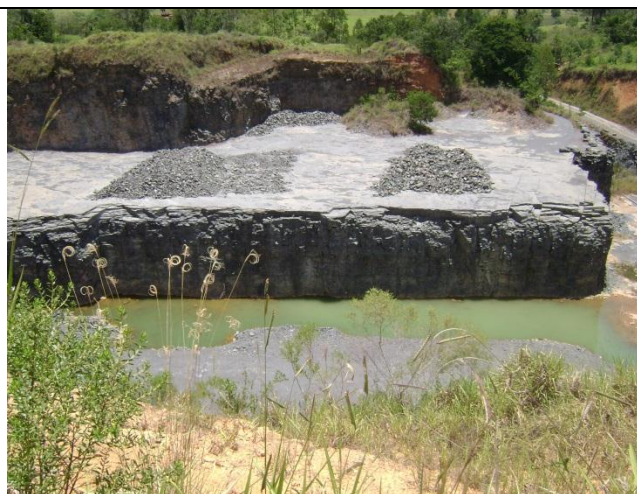
Foto 07: Vista geral da cava
