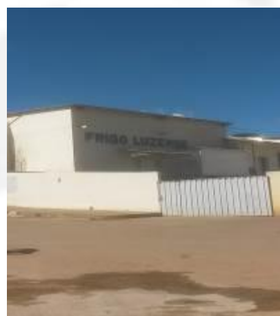
Foto 04. Portaria do empreendimento.
