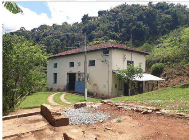
Foto 04. Casa de força
