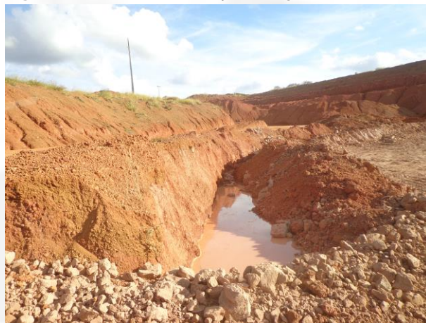
Figura 10. Canaleta de escoamento de água da mina
