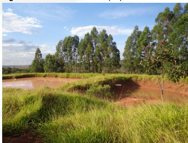
Figura 08. Bacias de contenção de água pluvial
