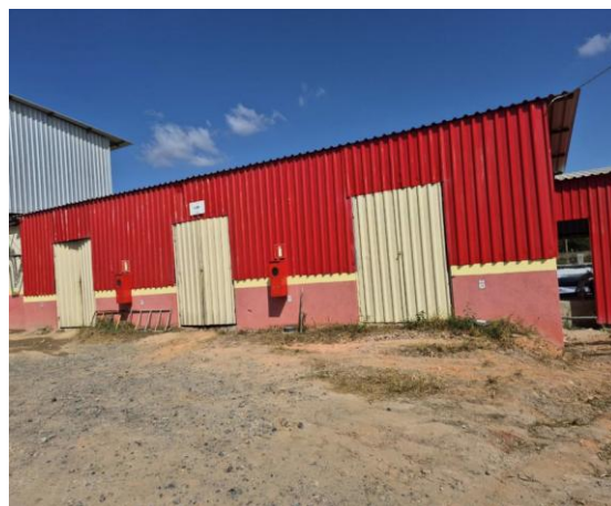
Foto 04. Depósito temporário de resíduos
