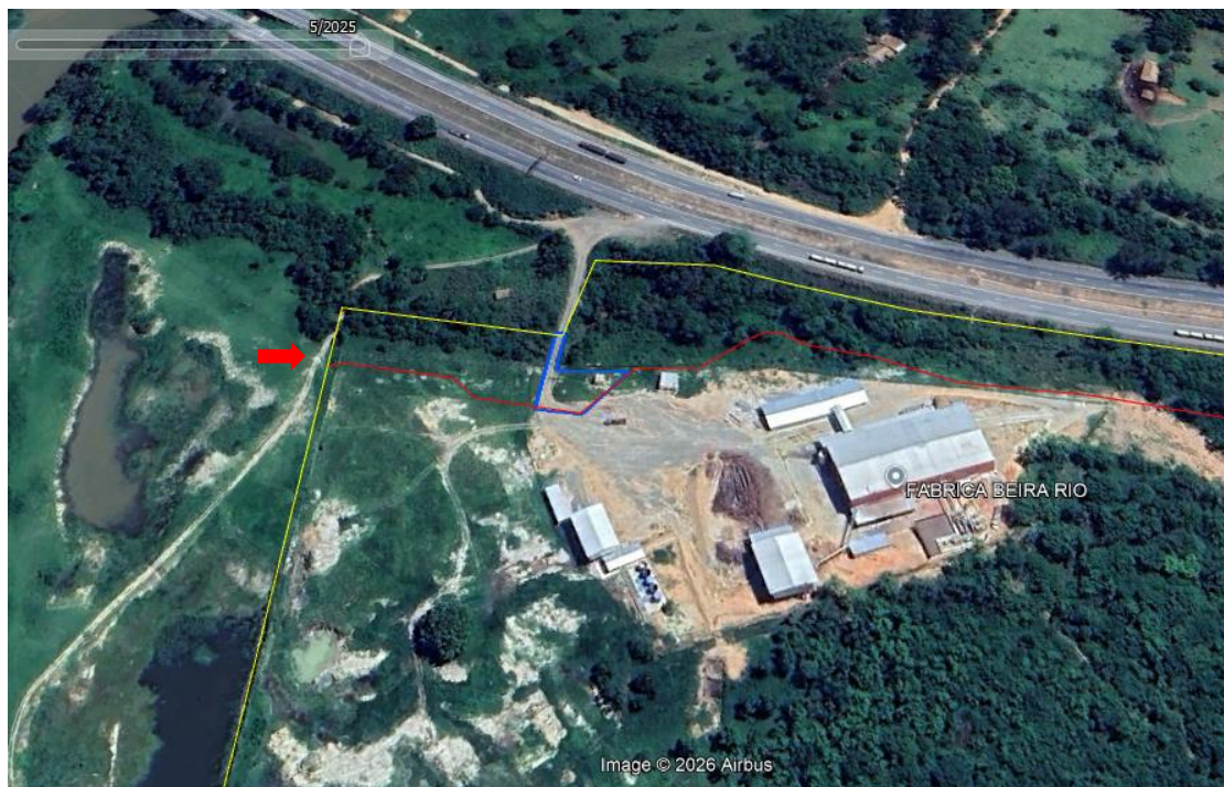
Figura 13. Seta vermelha indicando a estrada da qual partia o acesso ao imóvel.
