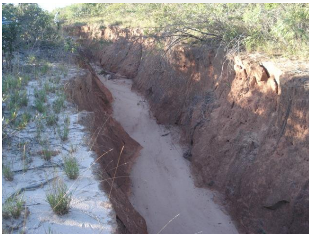
Foto 07. Erosão em antigo carreador
