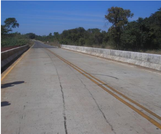
Foto 05. Vista parcial da Ponte do Córrego Cotovelo
