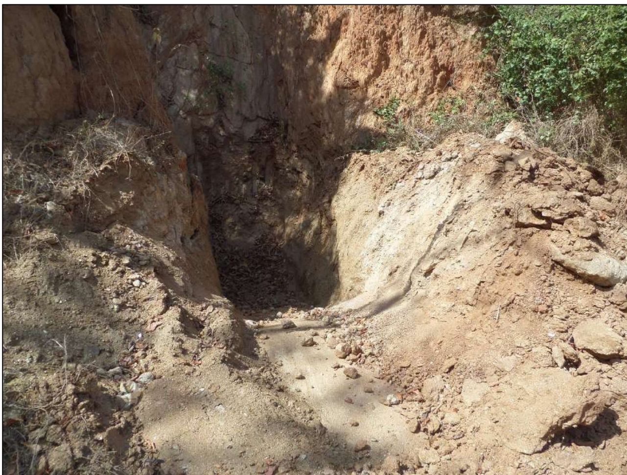
Figura 8 – Caixa seca presente no acesso a área do depósito de estéril.
