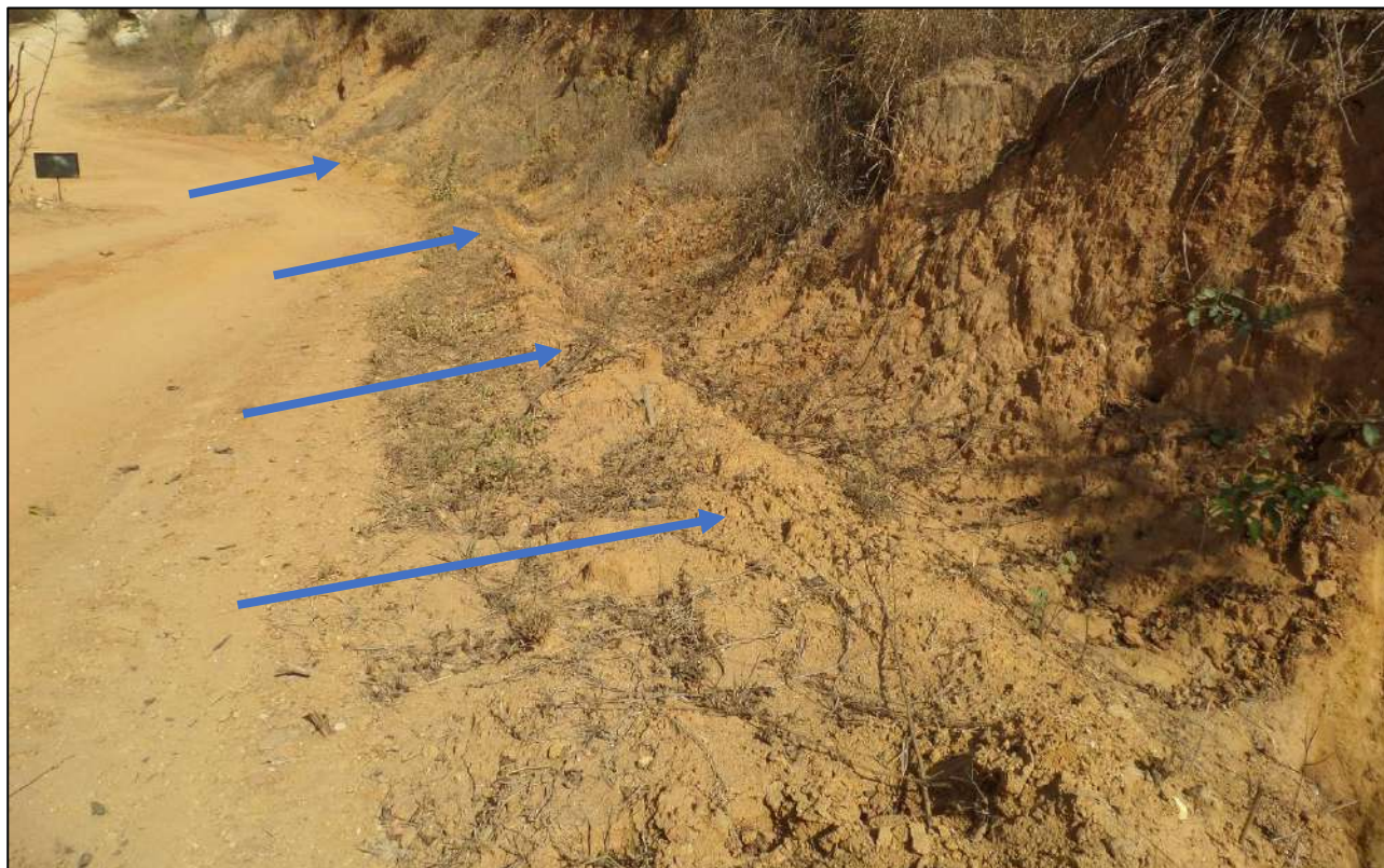
Figura 1 – Canaletas de drenagens direcionando o escoamento para as caixas secas instaladas no local de acesso a unidade de manutenção.
