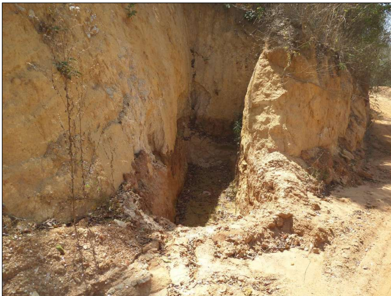
Figura 9 - Caixa seca presente no acesso a área do depósito de estéril.
