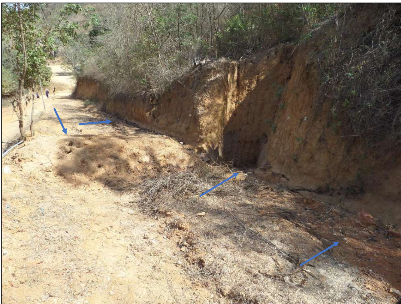
Figura 6 – Sistema de drenagem composto por lombadas e canaletas para direcionar o escoamento para caixas secas instaladas no local.
