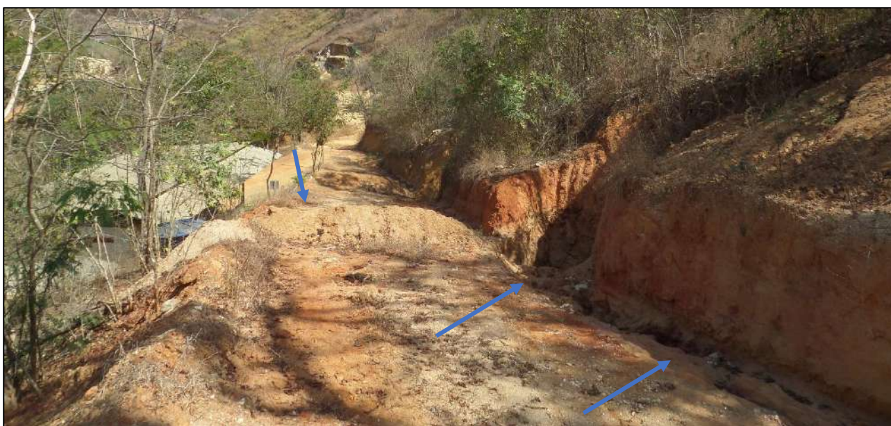
Figura 7 - Sistema de drenagem composto por lombadas e canaletas para direcionar o escoamento para caixas secas instaladas no local.
