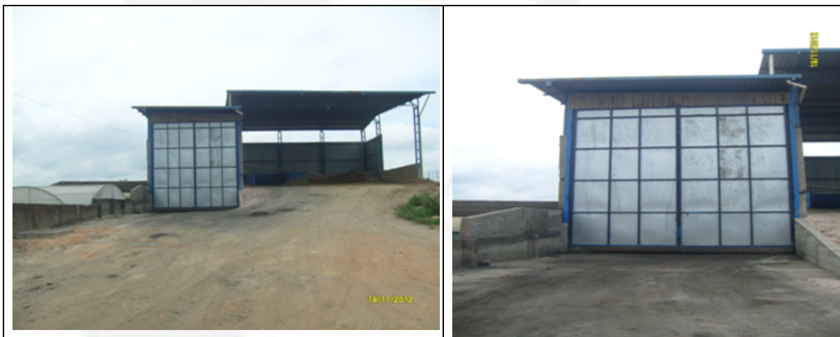
Fotos 01 e 02. Depósito do insumo siderúrgico -
