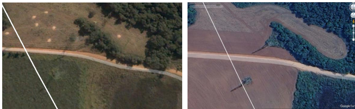
FIGURA 15 – Imagens de uma das torres que compõe a LT 345 kV Furnas-Itutinga C2 na data de junho de 2026 a direita e uma imagem de junho de 2003 a esquerda, nas coordenadas geográficas de referência 23 K 370531.76 m E e 7700760.87 m S. Fonte: Google Earth.
